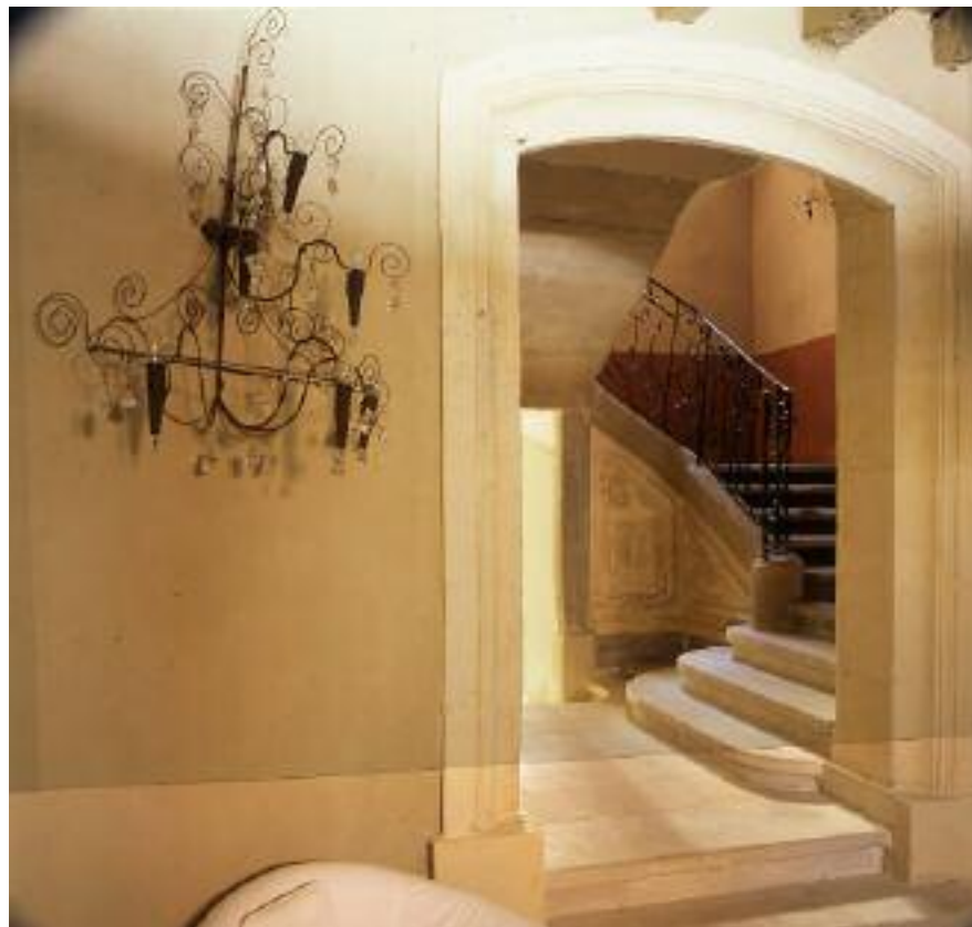
Autour de l'escalier central en pierre de taille, les murs ont été décorés à la chaux.
